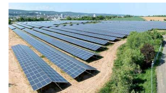
Afbeelding 1. Voorbeeld van een oost-westopstelling
